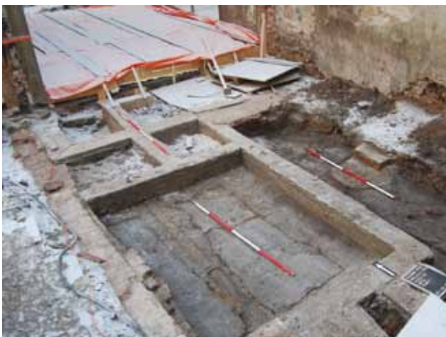
Afb. 17: De betonnen fundering die tegen de oostelijke zijmuur van het gotische kerngebouw is aangebouwd. Die zijmuur bevindt zich onder het oranje plastic.
