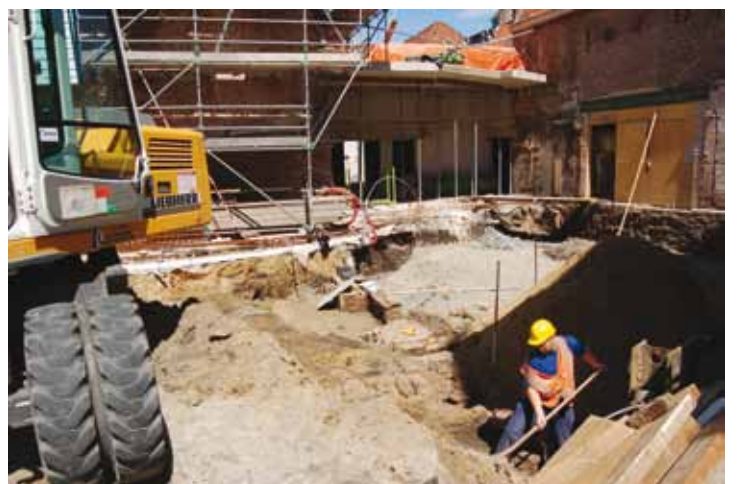
Afb. 8: Vrijleggen van de bakstenen poeren in werkput 5 van fase 3.
