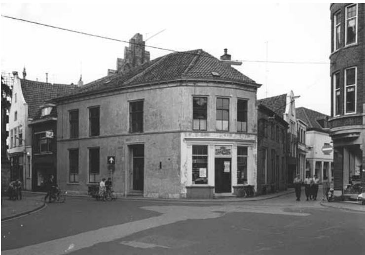
Afb. 34: het pand Kleine Poot 2 - Lange Bisschopsstraat 1 in de jaren vijftig van de 20 ste eeuw. Het pand was toen in gebruik als wasserij.
