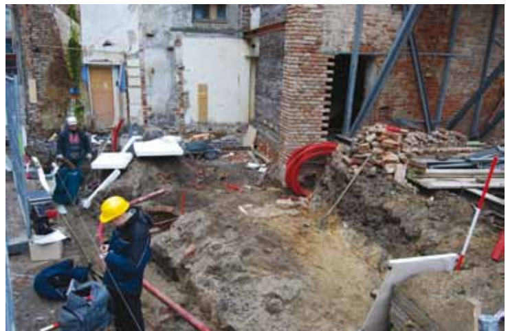
Afb. 7: Werkput 4 van fase 2 bestond uit een smalle sleuf langs de straat.
