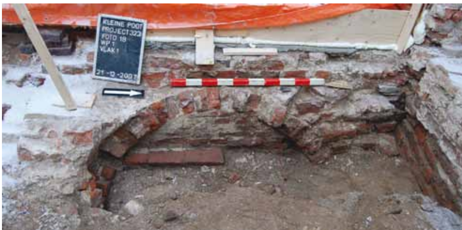
Afb. 15: De bovenzijde van de boog over de kelderingang in de oostelijke zijmuur van het gotische kerngebouw in werkput 1.
