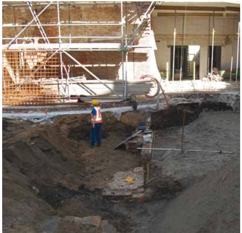
Afb. 19: De bakstenen poeren bevonden zich in een rechte lijn in het verlengde van de oostelijke zijmuur van het gotische kerngebouw.
