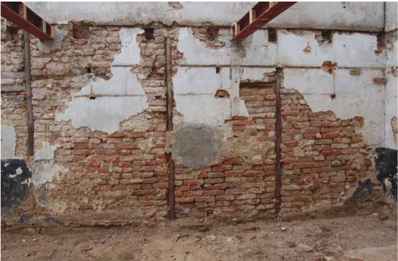
Afb. 28: De scheidingsmuur die het gotische kerngebouw vanaf 1644 in tweeën deelde was opgezet als vakwerkmuur onder een balk met korbeelstel.
